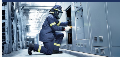
Arc Flash PPE
